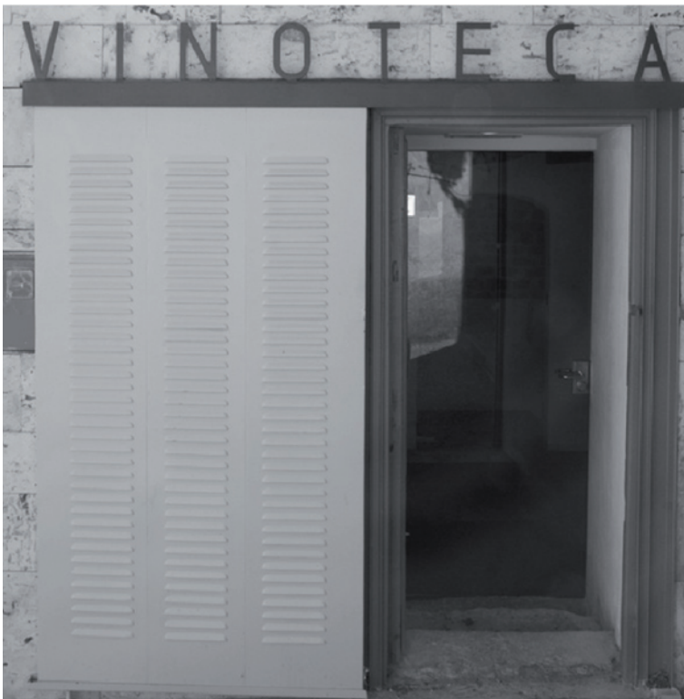
detalle ventana escaparate tienda
